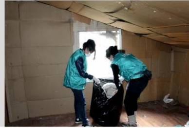
Limpieza de casa en mal estado de abuelitos.
